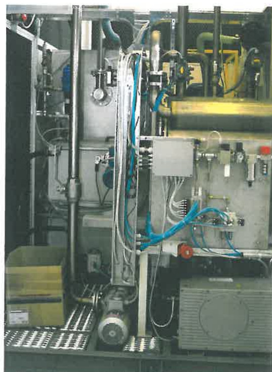
1 – L'interno di una delle macchine di lavaggio di Tecnofirma, viste durante la visita nel laboratorio di collaudo dell'azienda.
