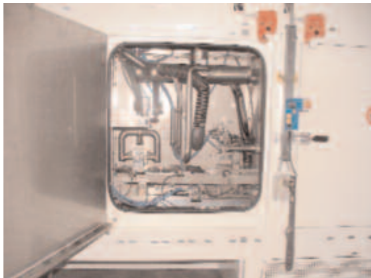
Un particolare dell'interno, dell'operazione di lavaggio/soffiaggio.
