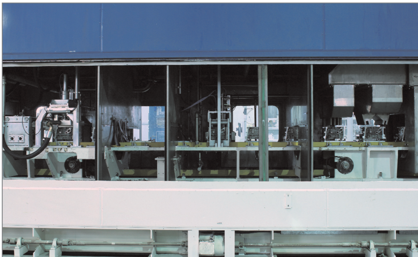
Vista interno impianto "lift & carry" per motori
