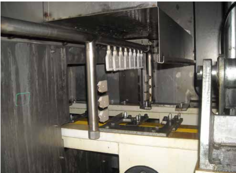
10 - Prima asciugatura generale, tramite soffiaggio.
