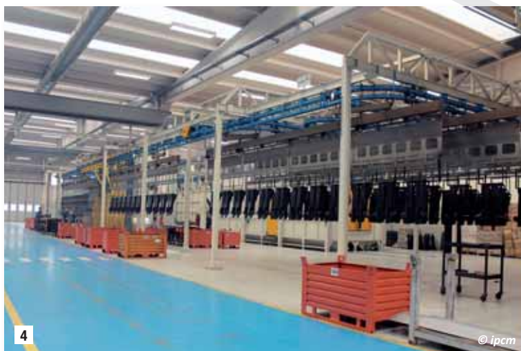
4 The loading and unloading area. La zona di carico e scarico.
