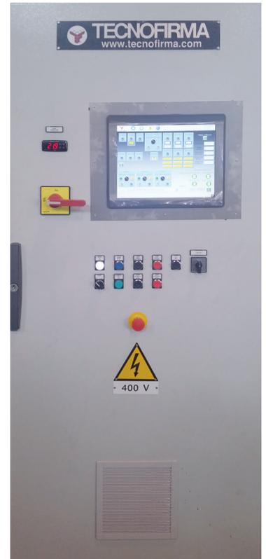
e condizionamento vernice, per garantire caratteristiche costanti della stessa durante l'applicazione. In alternativa all'utilizzo di robot, la macchina può essere anche dotata di pistole fisse o posizionate su oscillatori specifici, (a seconda della tipologia e dei pezzi da trattare). Tutti i comandi macchina sono centralizzati in un pannello operatore touch screen con grafica di facile utilizzo per l'impostazione di parametri operativi e dei relativi tempi di processo.
