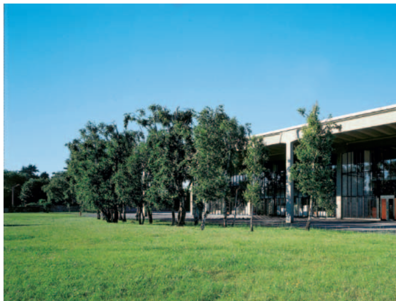
L’esterno dell’azienda e una vista degli uffici di Tecnofirma.
