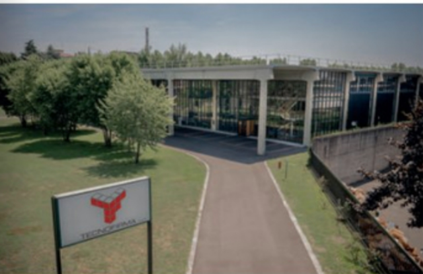
L'headquarter Tecnofirma di Monza e un impianto realizzato.
