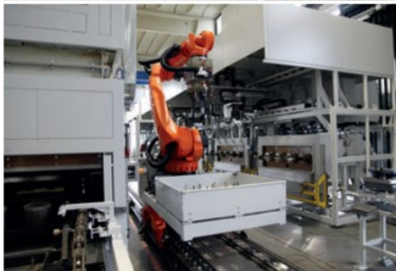
Alcuni esempi di impianti realizzati da Tecnofirma.
